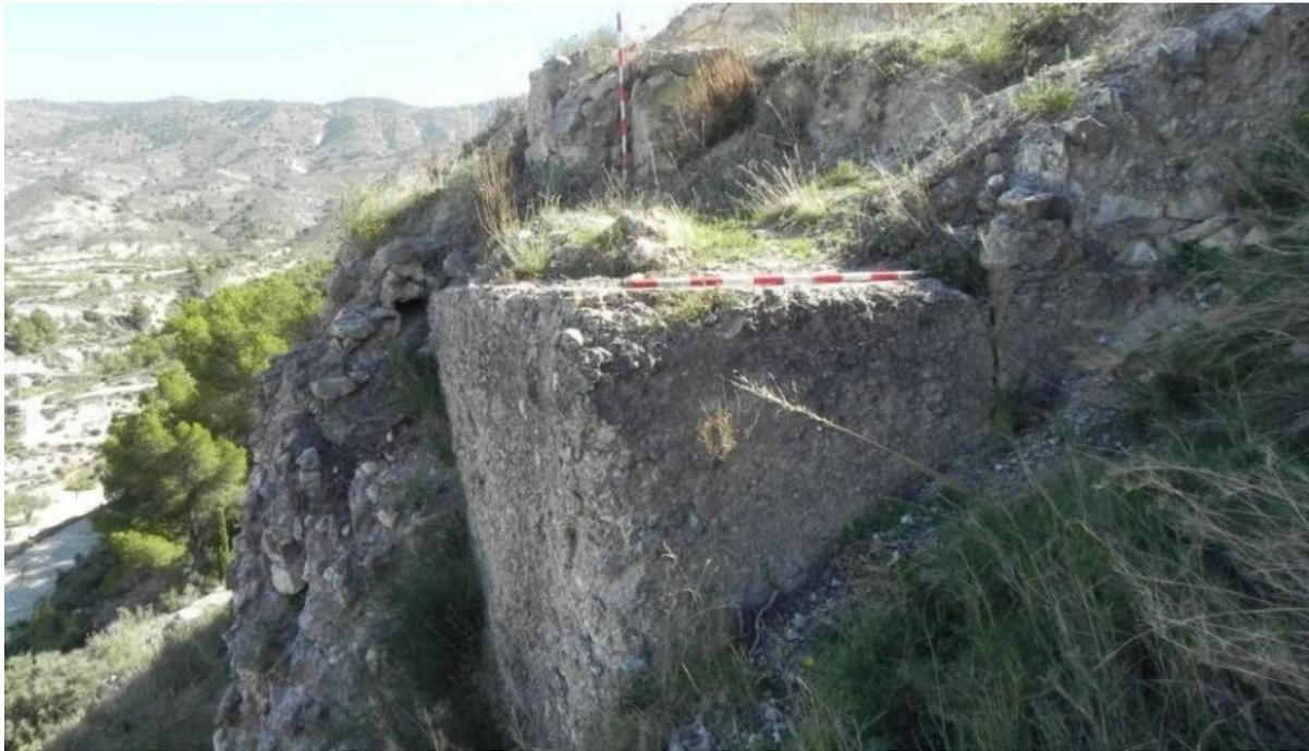
Esquina noroeste de la cimentación del aljibe inferior, se observa el inicio de su bóveda asentada sobre un muro encofrado de hormigón de cal de muy buena calidad
