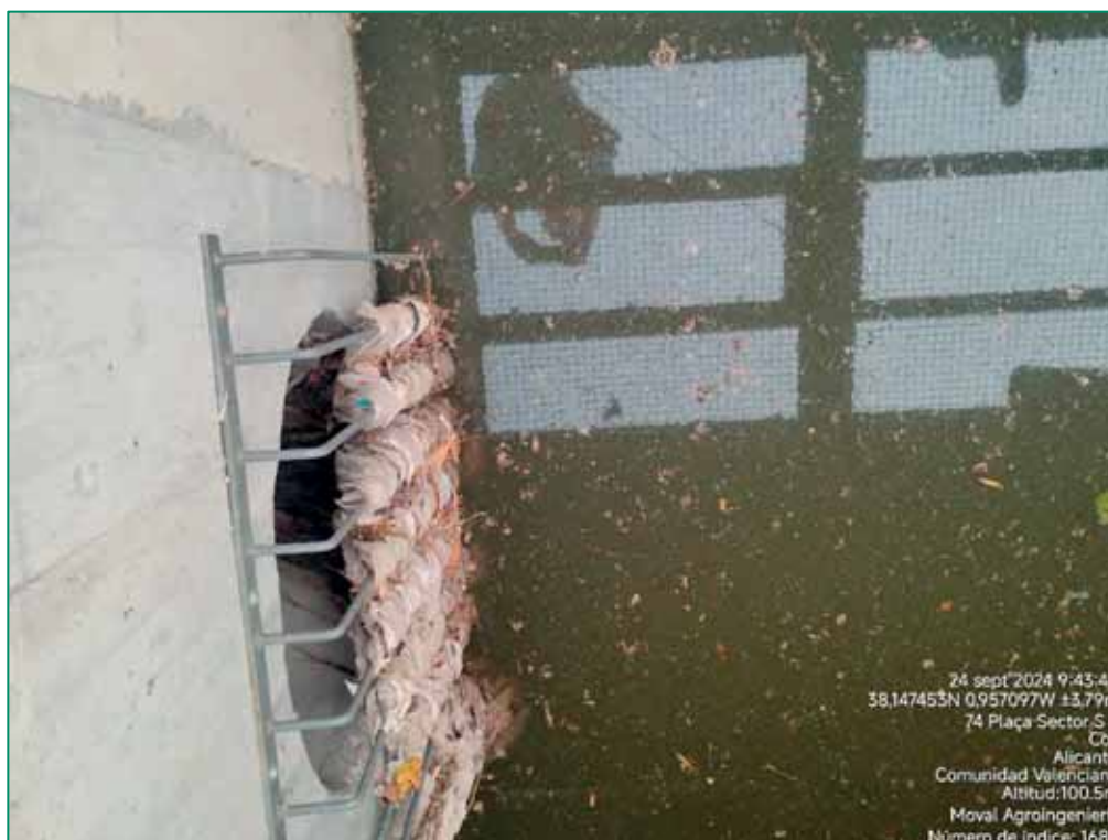
Figura 7. Reja situada en la entrada de la balsa de pluviales
