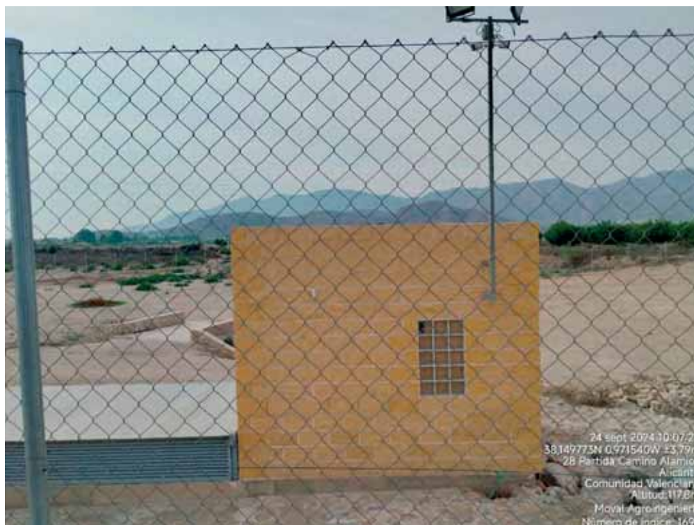
Figura 10. Caseta de cuadros adyacente a Balsa de Regulación.
