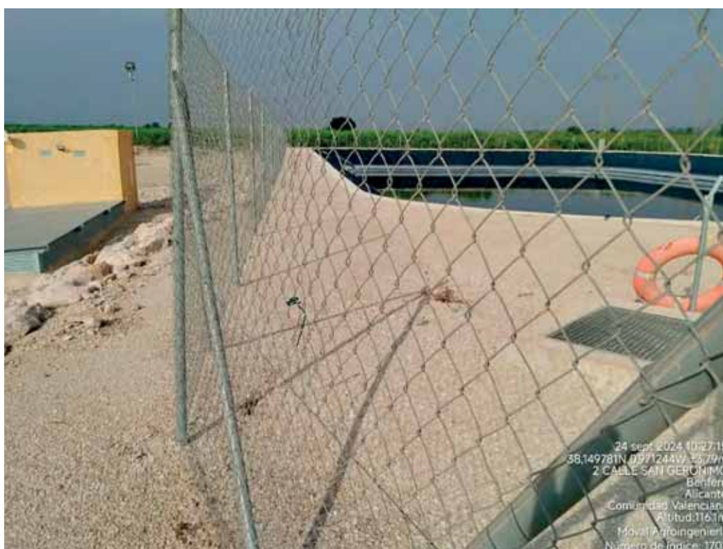
Figura 9. Vista camino de coronación balsa de regulación, ubicación de oxigenación.
