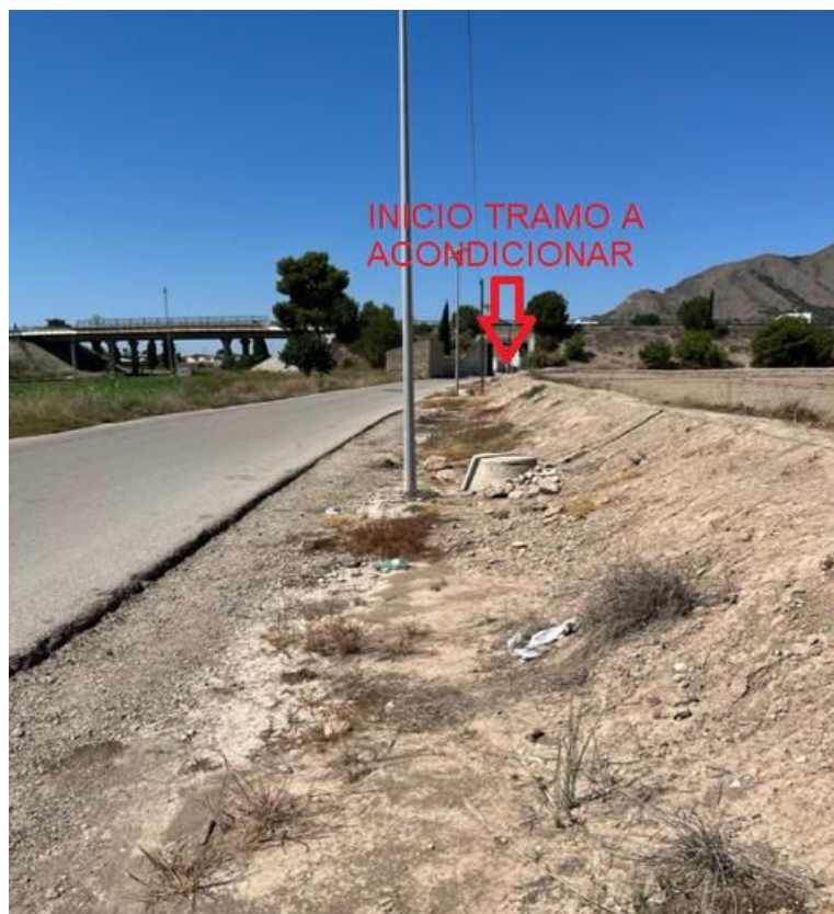
FOTOGRAFÍA N°1: VISTA DE LA CONDUCCIÓN EXISTENTE EN EL INICIO DE LA ACTUACIÓN
