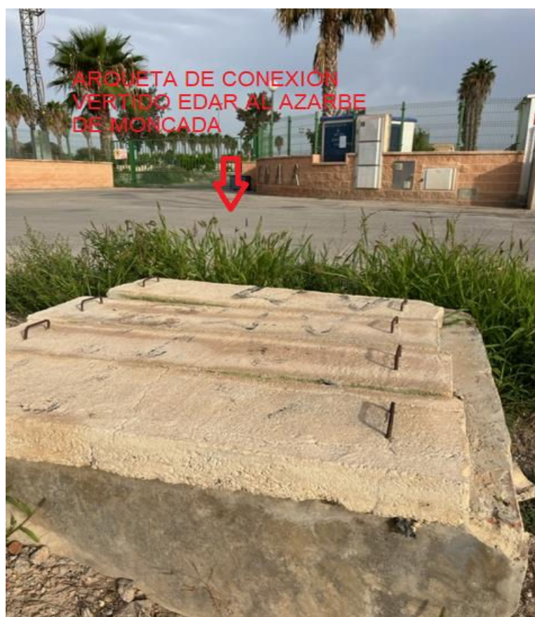
FOTOGRAFÍA Nº 6: VISTA DE ARQUETA DE CONEXIÓN DEL VERTIDO DE LA EDAR AL AZARBE
