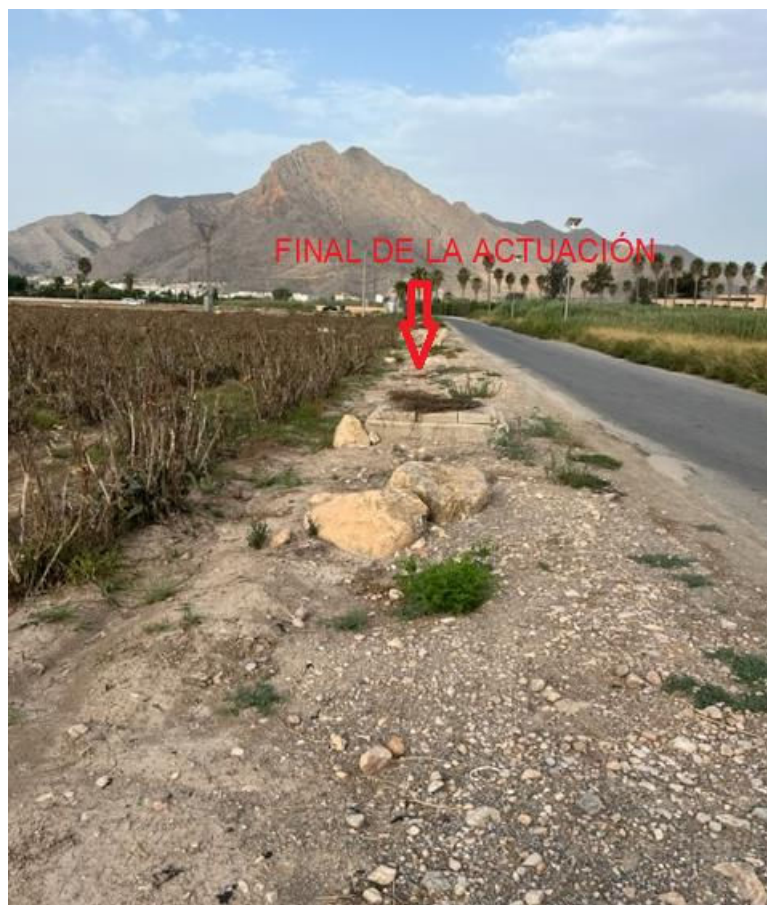
FOTOGRAFÍA Nº7: VISTA DE FINAL DE LA CONDUCCIÓN A REPARAR
