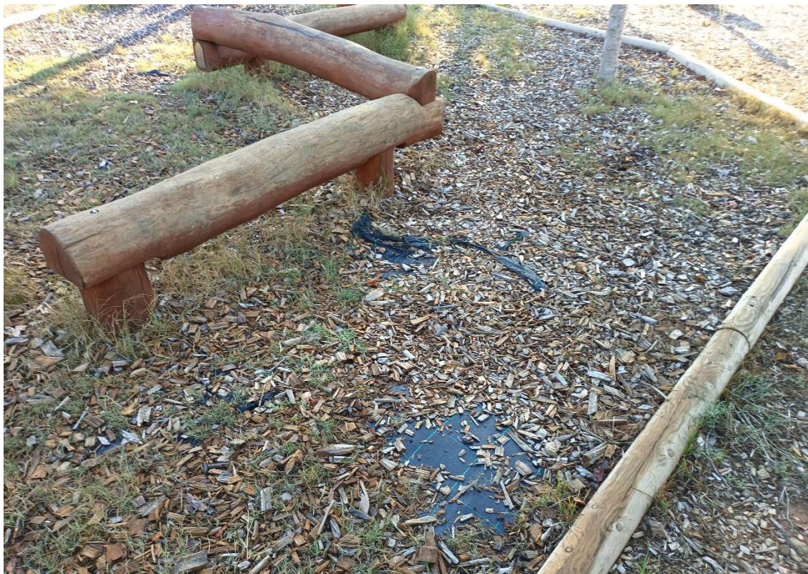
Estado actual del suelo de amortiguación de los juegos infantiles y de los elementos de madera
