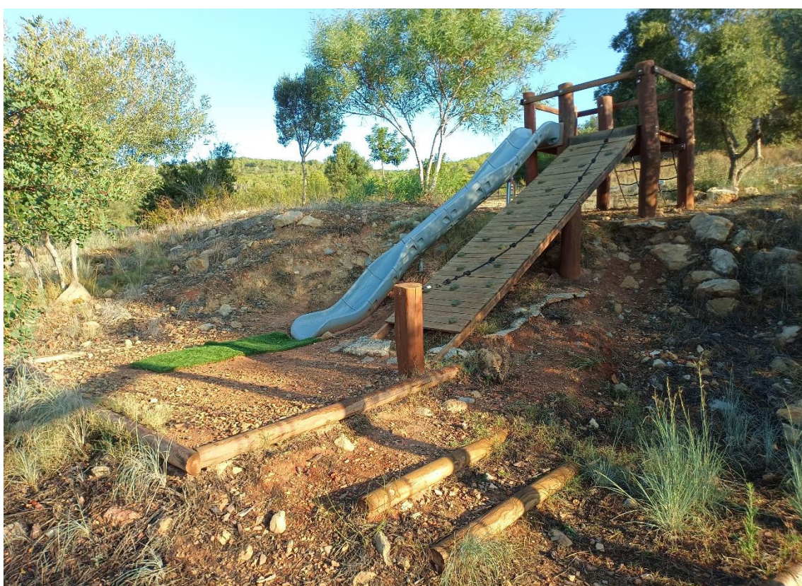
Estado actual del conjunto de Tobogán-rampa a adecuar
