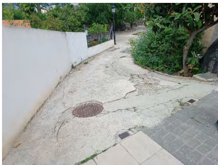
Último tramo a adecuar
