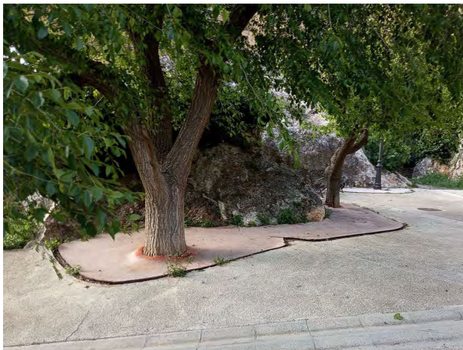
Una de las zonas con pavimento de caucho a adecuar.
