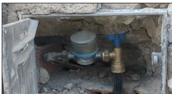
Contadores existentes en arquetas (C/ San Gregorio)
