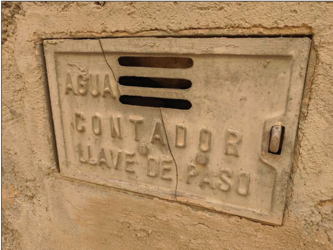
Foto nº 6. Puerta registro contador deteriorada en Pza. de la Iglesia.
