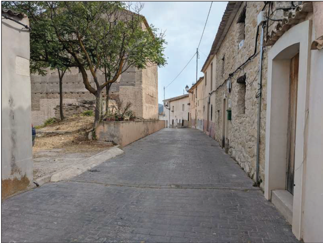
Foto nº 12. Vista general C/ del Castillo.
