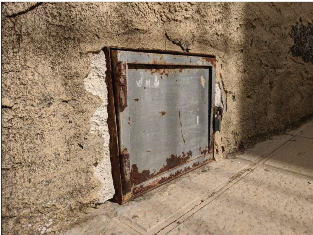
Foto nº 11. Puerta registro contador deteriorada en C/ Juez Hernaez.
