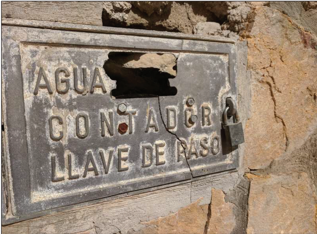
Foto nº 8. Puerta registro contador deteriorada en C/ del Sol.
