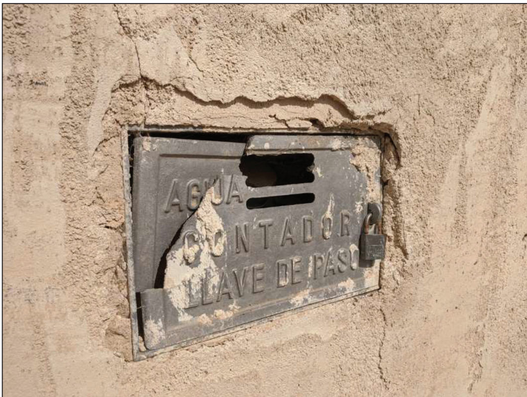
Foto nº 9. Puerta registro contador deteriorada en C/ de la Abadía.
