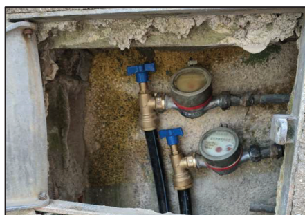
Contadores existentes en arquetas (C/ San Gregorio)
