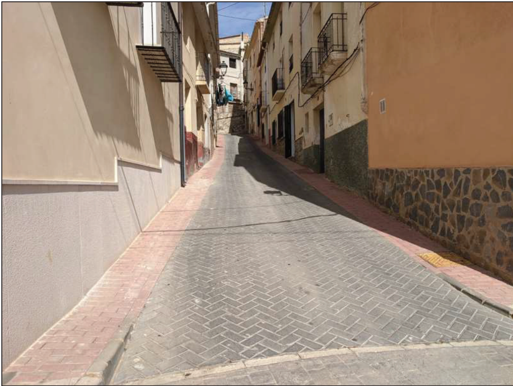
Foto nº 4. Vista general C/ de Mossen Victoriano Garrigós.
