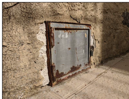
Puertas de registro de contadores deterioradas y con roturas
