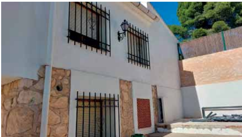
BALCÒ FABANELLA EXTERIOR
