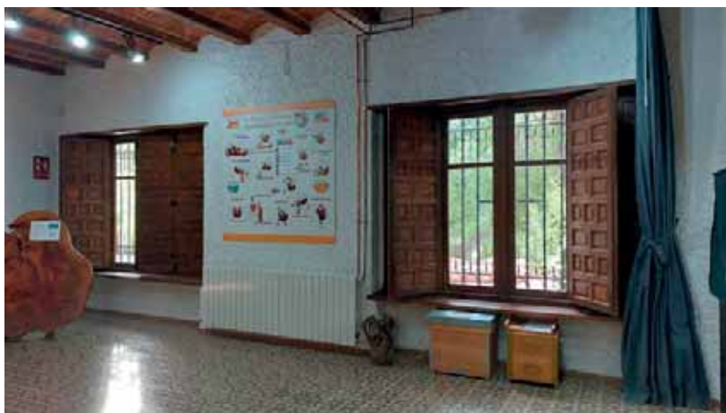
CASA TÁPENA VENTANAS INTERIOR
