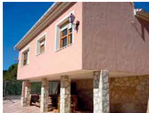
BALCÒ FABANELLA EXTERIOR
