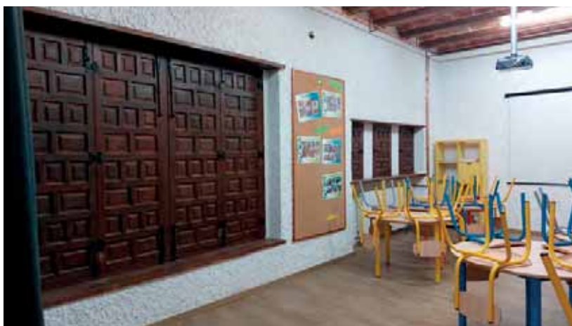
CASA TÁPENA VENTANAS INTERIOR
