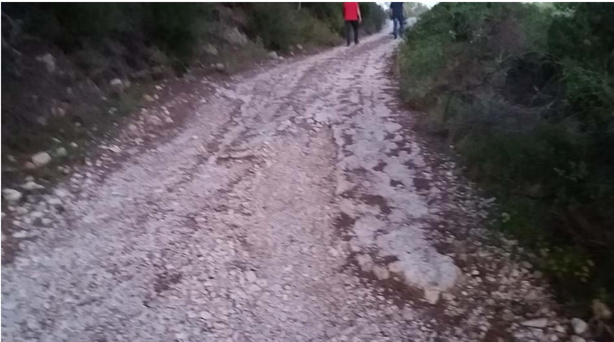
Vistas del tramo "Fortins 1", con solera existente deteriorada, que se prevé demoler previa reposición de la misma con mallazo.
