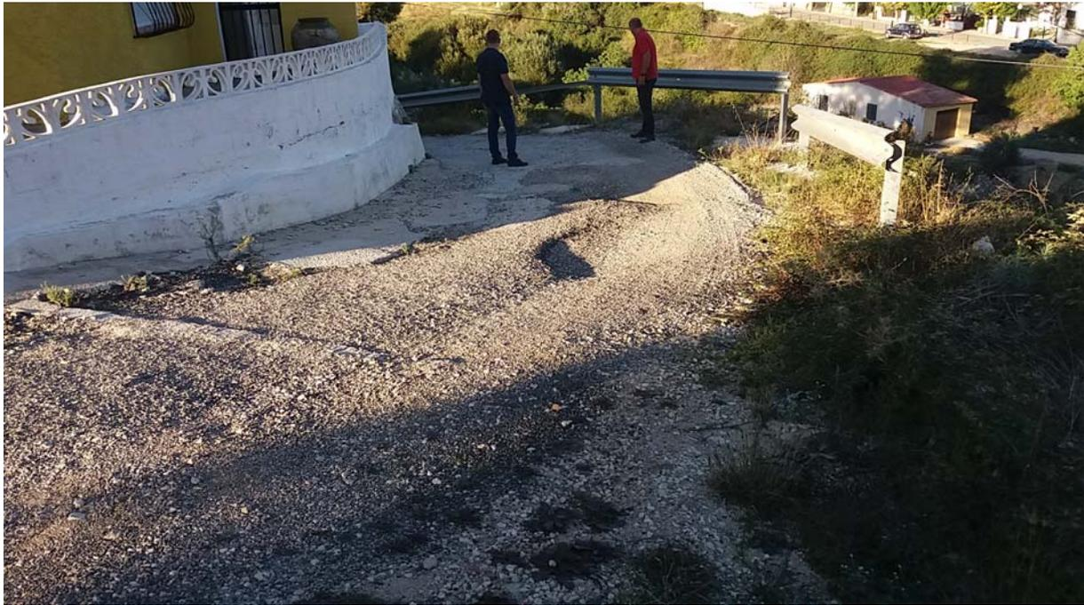
Vista del tramo "Vinyes 1", donde se pavimentará con hormigón tras sanear los baches.
