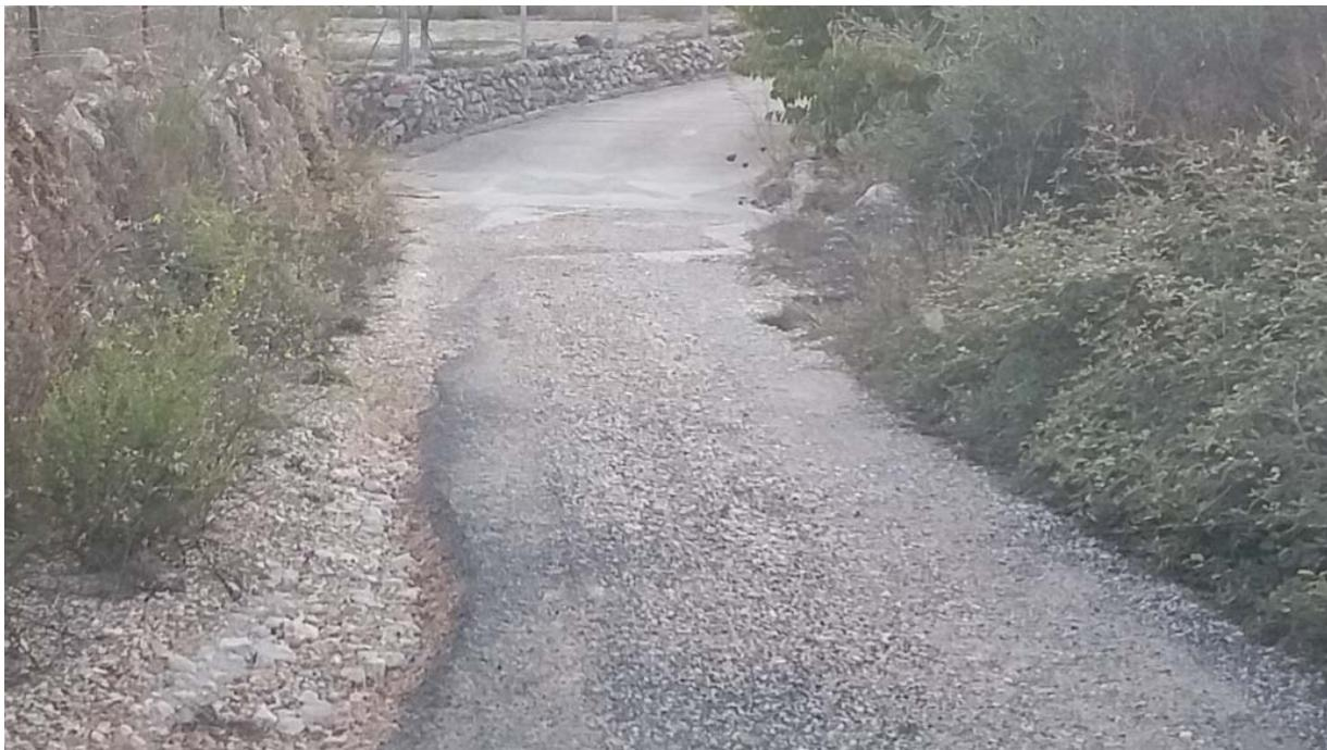
Tramo "Vinyes 3" donde se proyecta bachear con hormigón HNE-20 la zona lateral erosionada por el agua.
