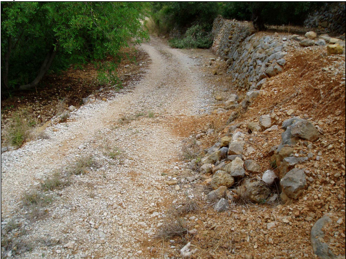
Fotografía nº4: El camino se estrecha en algunos puntos. Las lluvias han provocado la caída de mampostería de un bancal.
