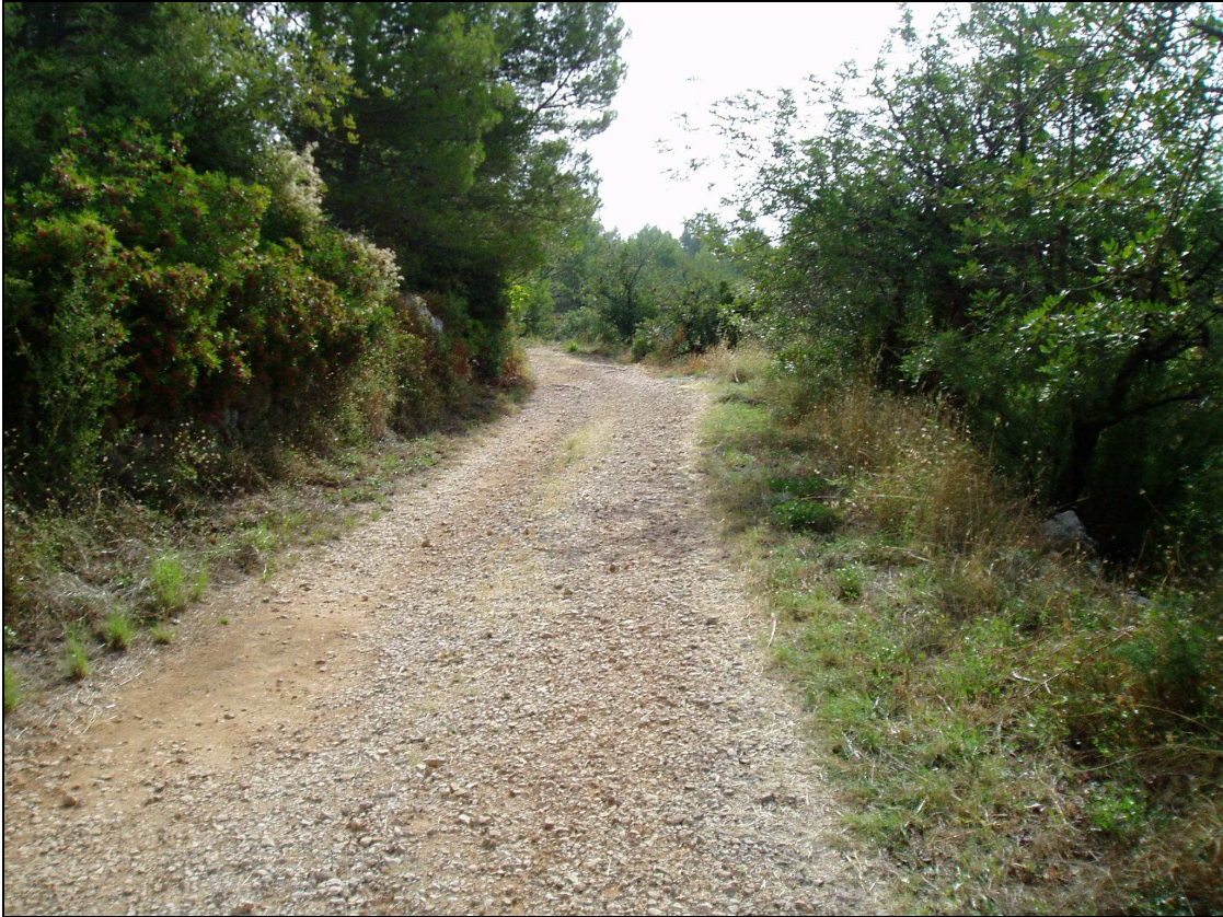
Fotografía nº11: Este último tramo, de unos 300 m.l., el camino presenta la zahorra muy suelta y ancho variable.
