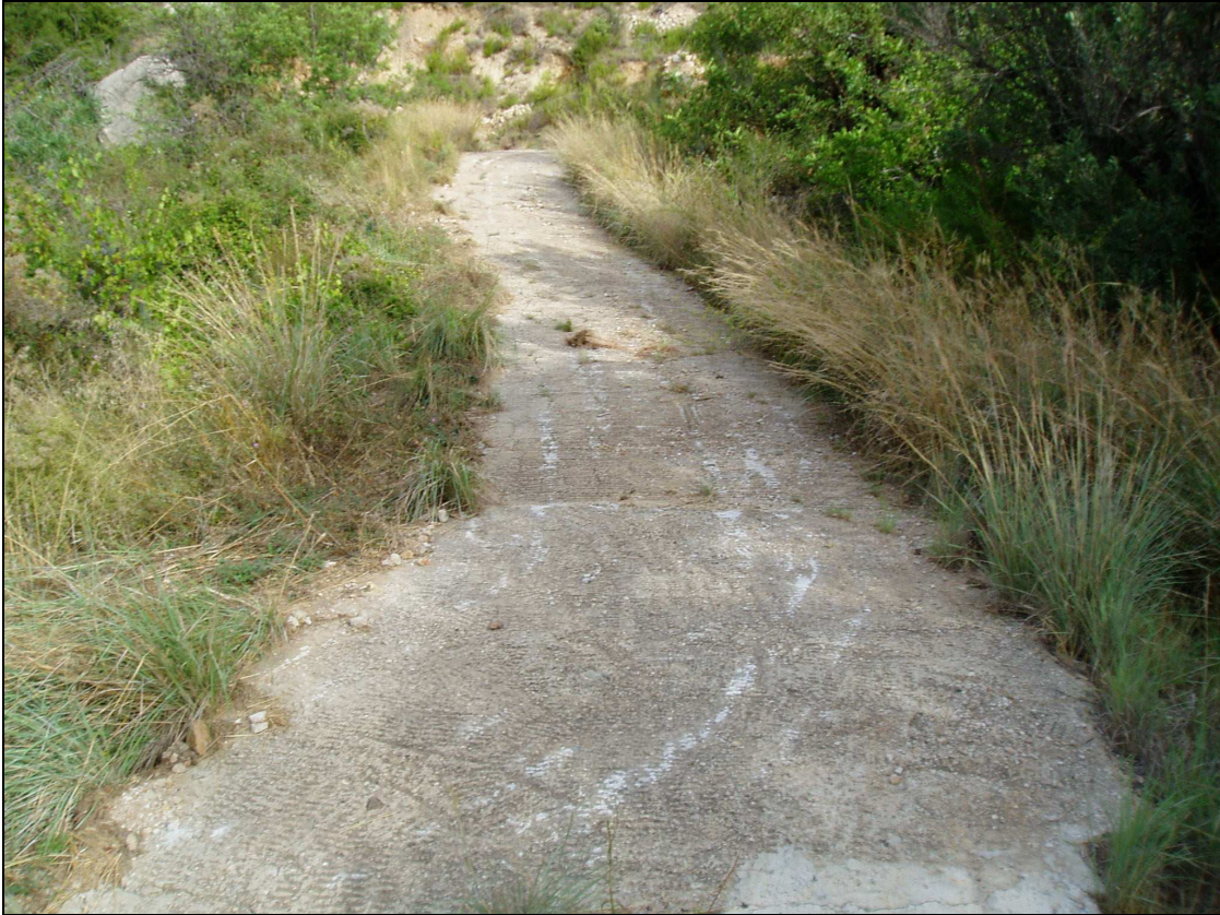
Fotografía nº5: Tras 400 metros de camino en zahorras, el camino pasa a ser de nuevo de hormigón por el incremento de las pendientes.
