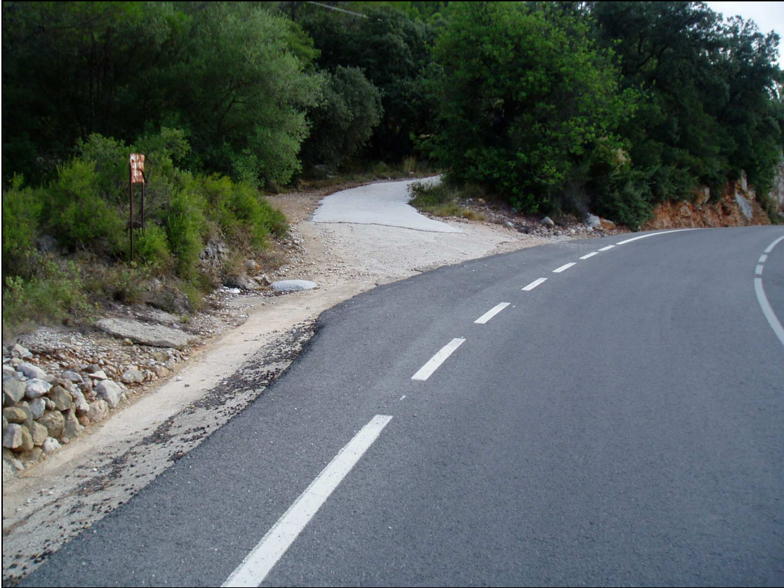
Fotografía nº1: Inicio de la actuación junto a la carretera CV-719. En esta zona se ampliará el abanico de hormigón para mejorar el acceso a la carretera.
