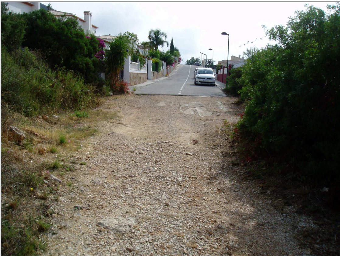
Fotografía nº12: Final de la actuación al llegar a una zona urbanizada.
