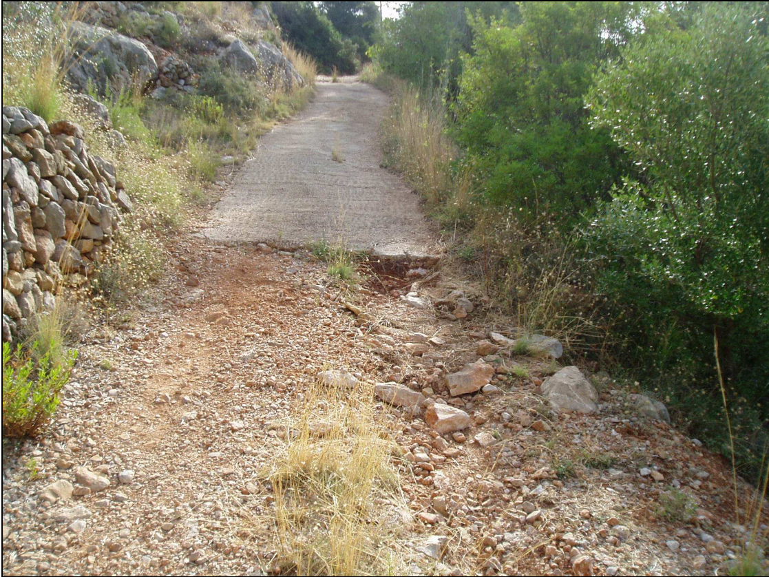
Fotografía nº9: Al incrementar su pendiente, encontramos un tercer tramo de camino de hormigón. Se puede observar la erosión del agua que baja sobre el pavimento.
