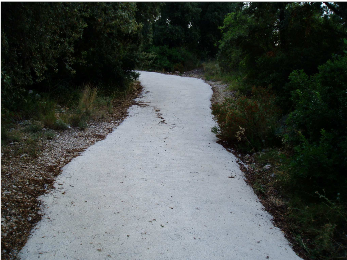
Fotografía nº2: En sus primeros 100 metros el camino es de hormigón en buen estado. Aquí se ejecuta un refuerzo con aglomerado.
