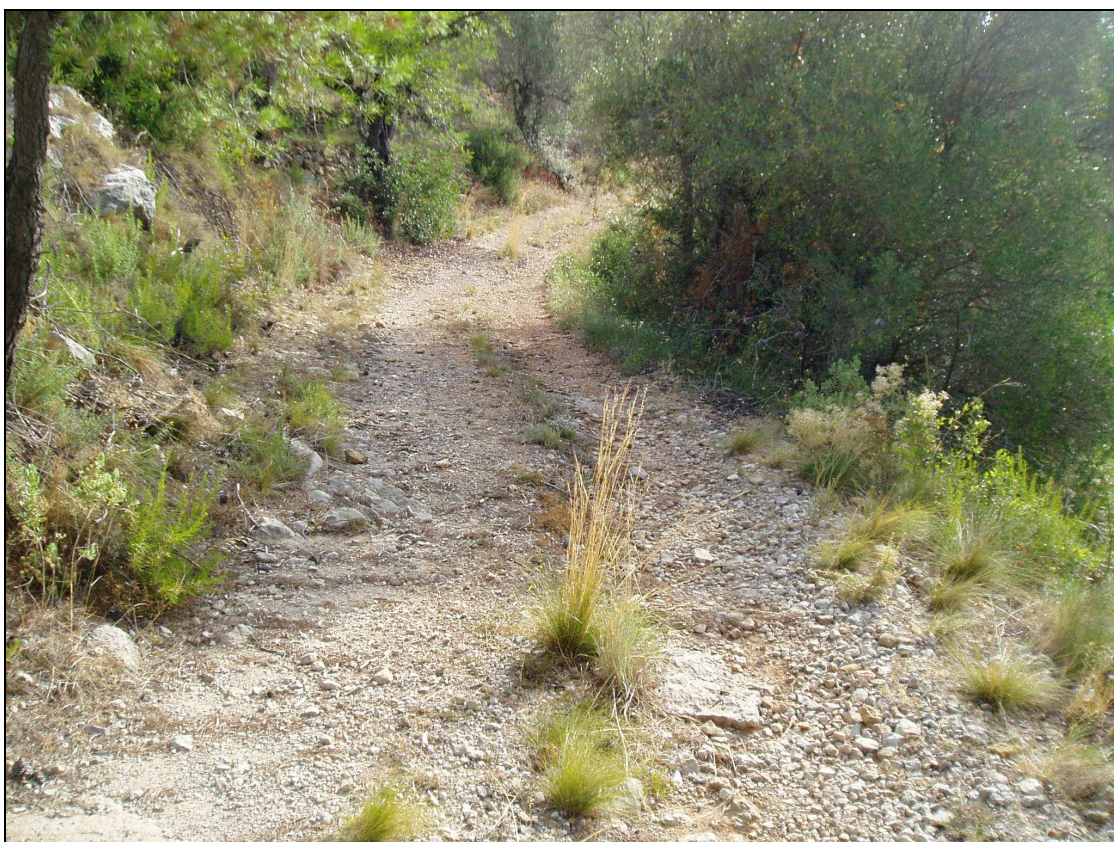
Fotografía nº8: Este tramo, de unos 100 metros de longitud, presenta una pendiente más suave y la zahorra muy deteriorada.
