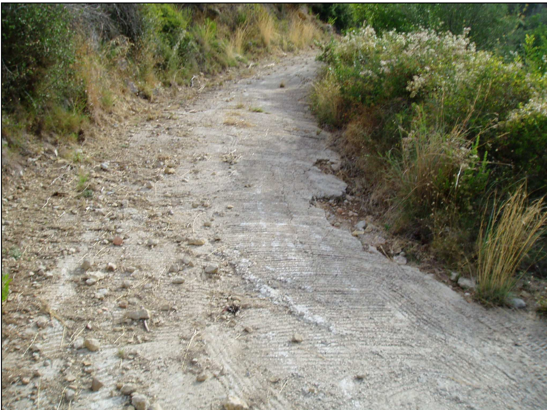
Fotografía nº6: Este segundo tramo en hormigón presenta abundantes arrastres y zonas que precisan una reparación.
