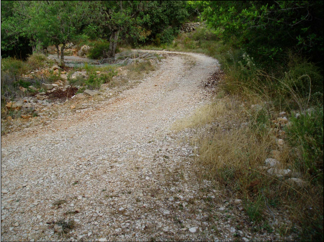
Fotografía nº3: Tras el tramo de hormigón inicial, el camino pasa a ser de zahorra muy suelta.
