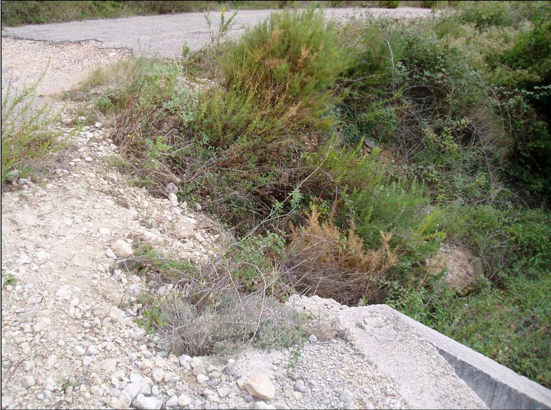
**Fotografía nº3:** En tres puntos del camino (junto a 2 obras de fábrica) las aguas han socavado el talud, por lo que se empleará escollera para repararlo.
