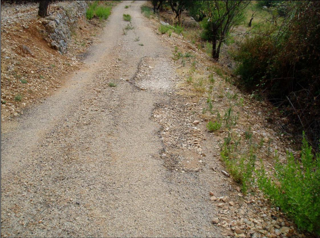
**Fotografía nº7:** Ejemplo de zona donde previo a la extensión de la nueva capa de rodadura se deberá parchear el aglomerado.
