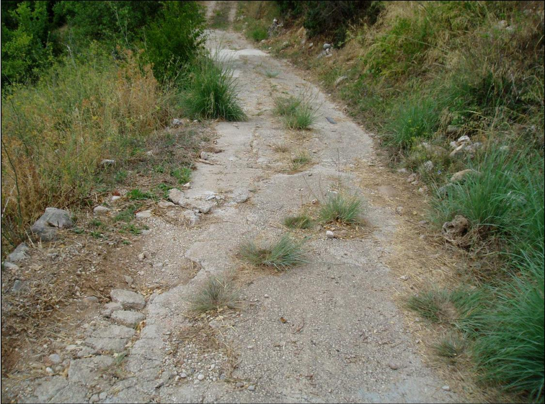
**Fotografía nº11:** El hormigón está muy deteriorado por la acción de las aguas que bajan hacia el río a gran velocidad debido a la pendiente.
