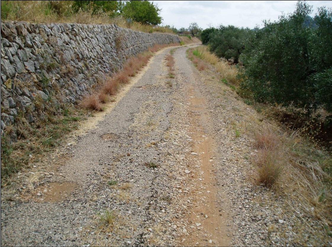
**Fotografía nº9:** En este segundo tramo, se escarificará el camino, se mejorará el material con adición de zahorra artificial ZA-25 y se generará una nueva base.
