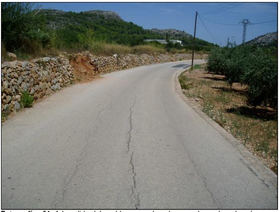
Fotografía nº4: A la salida del pueblo se pueden observar derrumbes de márgenes y la fisuración del aglomerado.
