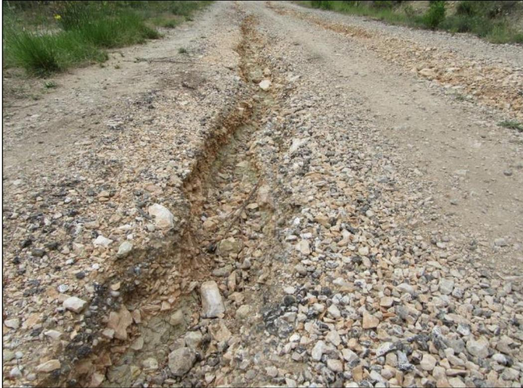
*Foto 4. Erosión de pavimento*
