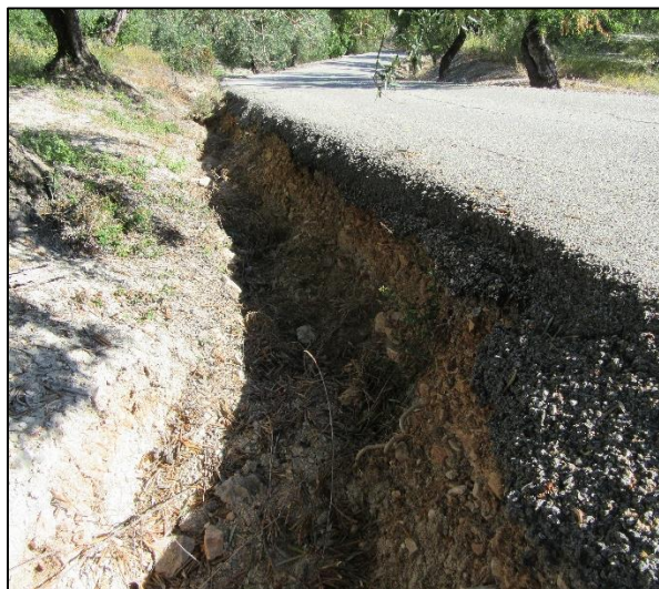
Cuneta erosionada y descuelgue de calzada
