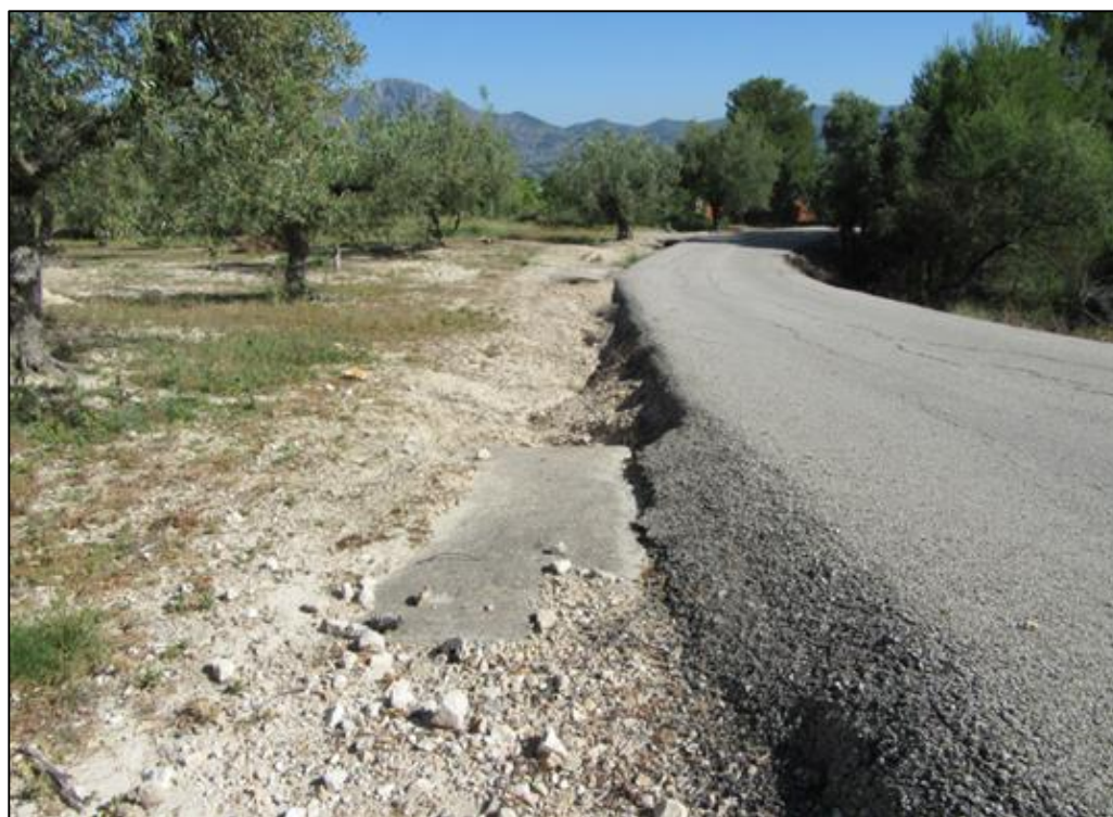
Foto 3. Erosión en cuneta y pasos salvacunetas obstruidos
