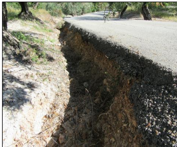
Cuneta erosionada
