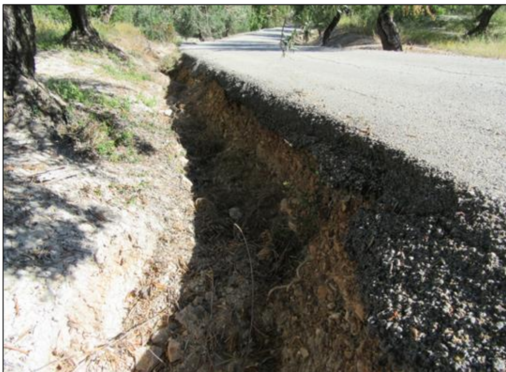
Foto 5. Erosión en cuneta
