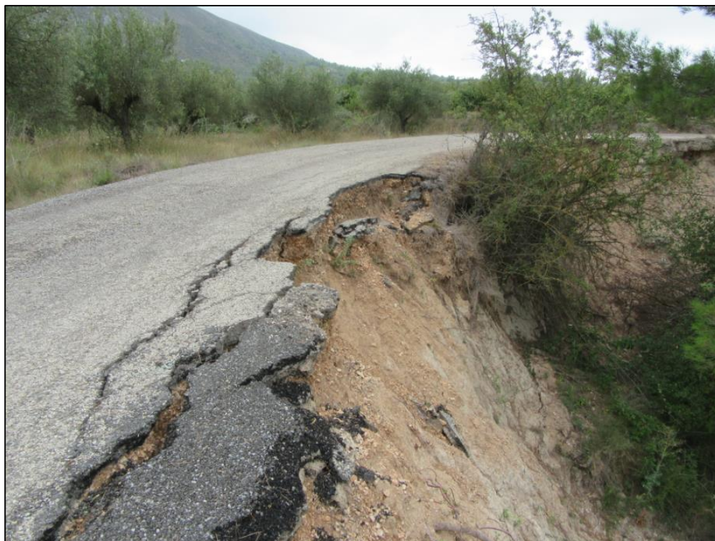
Foto 8. Descuelgue / rotura de calzada
