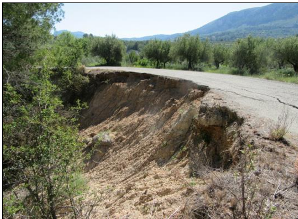
Foto 7. Descuelgue / rotura de calzada
