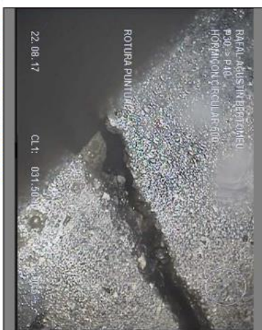
Foto: 6_17A, MPEG #: 1_AGUSTIN BE_0, 00:09:50 31.5m, ROTURA PUNTUAL
