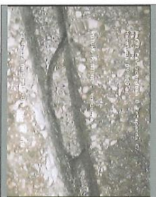
Foto 1_11A_001035 18,2m, ROTURA PUNTUAL, en junta
