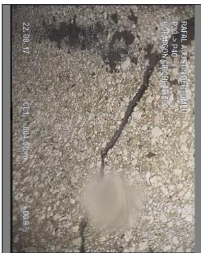
Foto: 6_68, MPEG #: 1_AGUSTIN BE_0, 00:01:32 4.5m, ROTURA PUNTUAL
