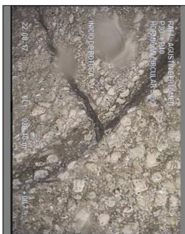
Foto: 6_15A, MPEG #: 1_AGUSTIN BE_0, 00:08:32 29,4m, INICIO DE ROTURA
