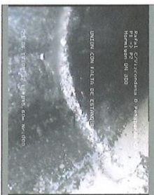
Foto 1_5A_000812 19,6m, UNION CON FALTA DE ESTANQUEIDAD
