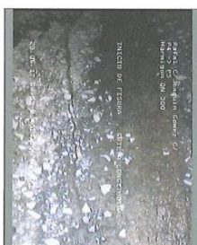
Foto: 3_9A, 00:10:36 14,1m, INICIO DE FISURA
