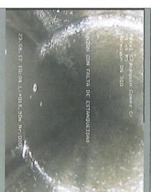
Foto: 3_14A, 00:14:58 19,9m, UNION CON FALTA DE ESTANQUEIDAD
