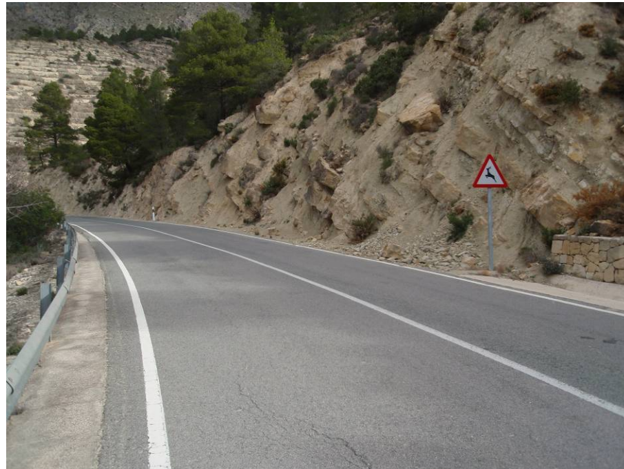
PK 13+550. Inicio de actuación en el final de la cuneta revestida existente.
