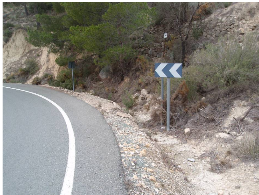
PK 18+410. Cuenta existente a revesitir de hormigón y ejecución de murete para contener derrames pequeños del talud.
