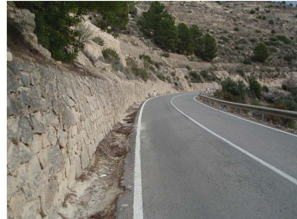
Fotografía 2: Pequeñas cunetas en el margen derecho en el mínimo espacio que existe (la imagen está tomada con vista en dirección de PKs decrecientes).
