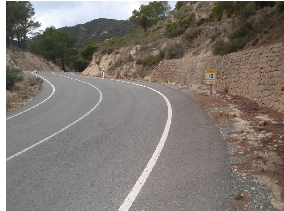
PK 19+000. Espacio en margen derecho suficiente para generar cuneta revesida de hormigón para encauzar las aguas de escorrentía a la obra de fábrica situada en el PK 18+980.
