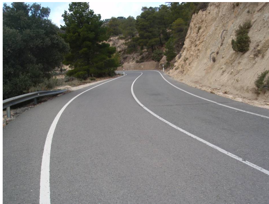
PK 18+950. Ídem respecto a la cuneta del margen derecho.
