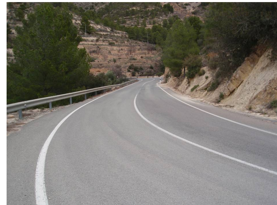
PK 17+200. Derrames de talud en el margen derecho. Necesidad de cuneta en dicho margen con murete de guarda para acumular los pequeños derrames.
