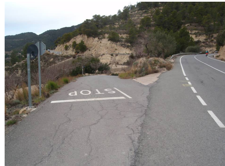
PK 18+300. Entrada a camino asfaltado. Resposición de señalización vertical y horizontal en el acceso.
