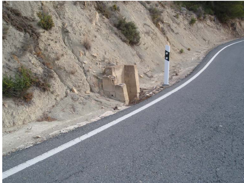
Fotografía 3: Obra de fábrica de drenaje transversal.
