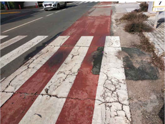
Reparación firme en senda ciclo-peatona
