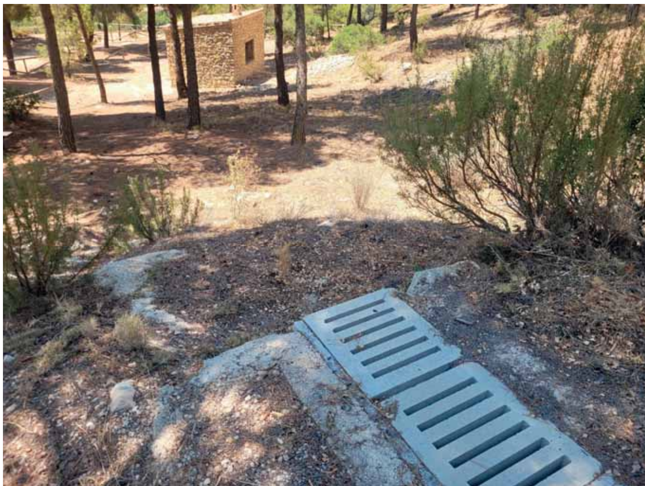
FOTO 3. Salida de aguas pluviales en camino de acceso
