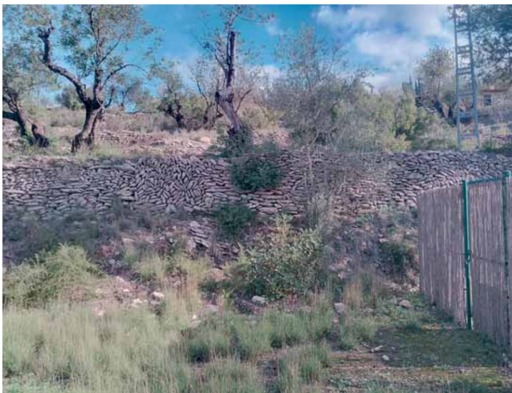
Foto nº08. Zona de aparcamiento. Vista general de muro de piedra seca en buen estado
