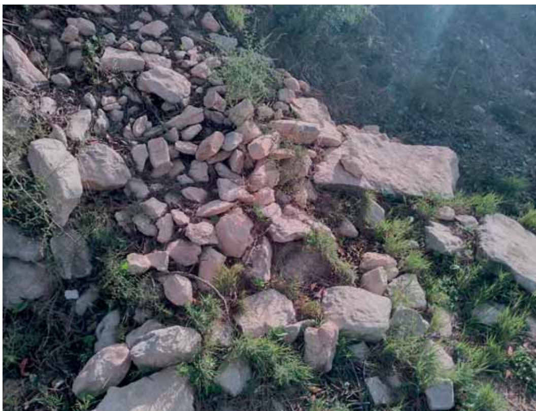
Foto nº04. Zona de aparcamiento. Detalle del tipo de piedra empleado en los muros de piedra seca existentes
