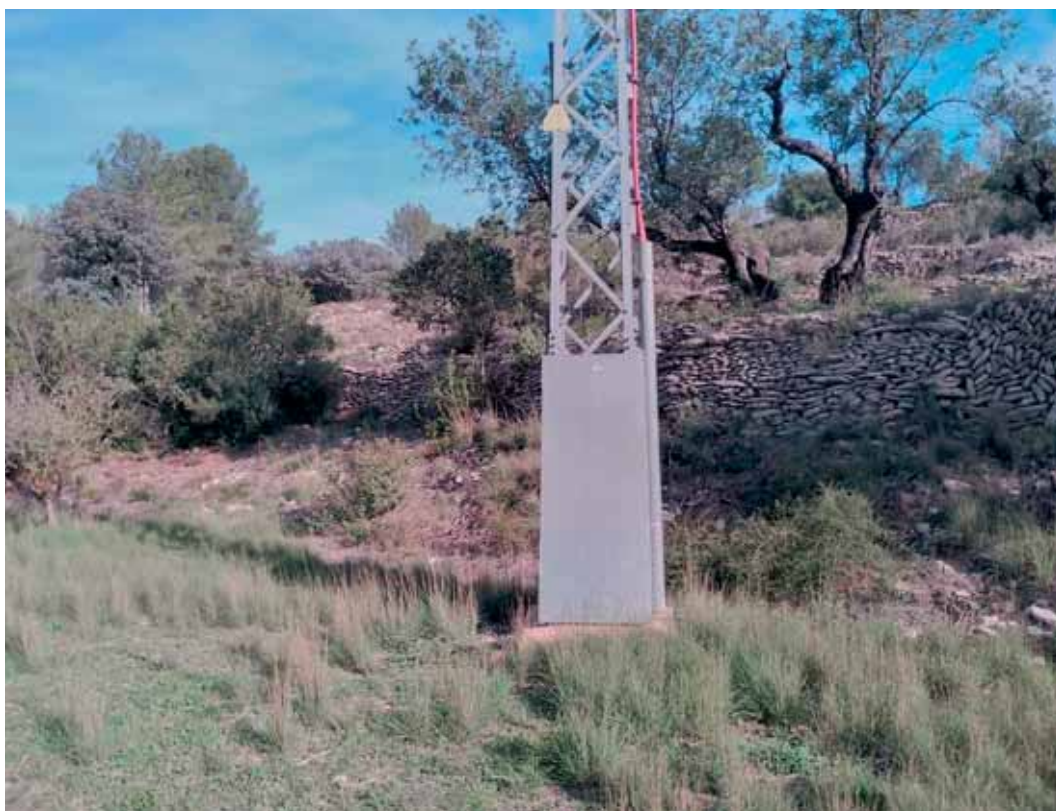
Foto nº10. Zona de aparcamiento. Vista general de muro de piedra seca en buen estado
