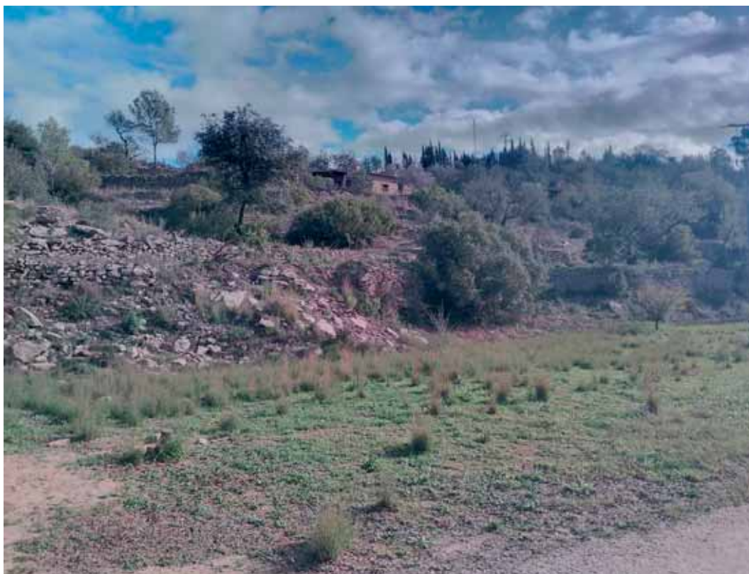
Foto nº07. Zona de aparcamiento. Vista general del primer nivel de terraza con su muro de sostenimiento, vencido en algunos puntos
