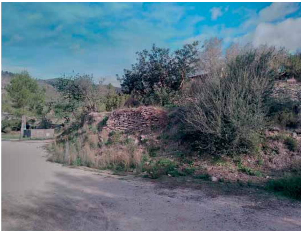
Foto nº03. Zona de aparcamiento. Detalle de tramo de muro de mampostería de piedra seca
