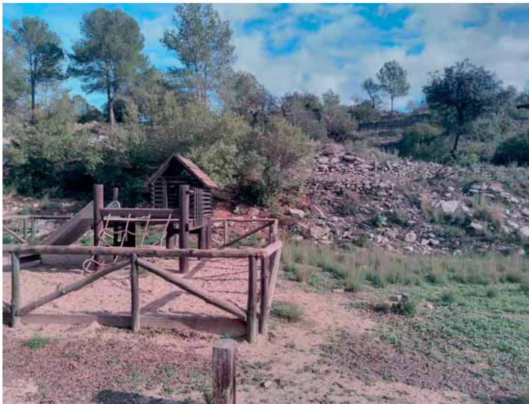
Foto nº11. Zona de aparcamiento. Zona donde se ha perdido el muro de piedra seca
