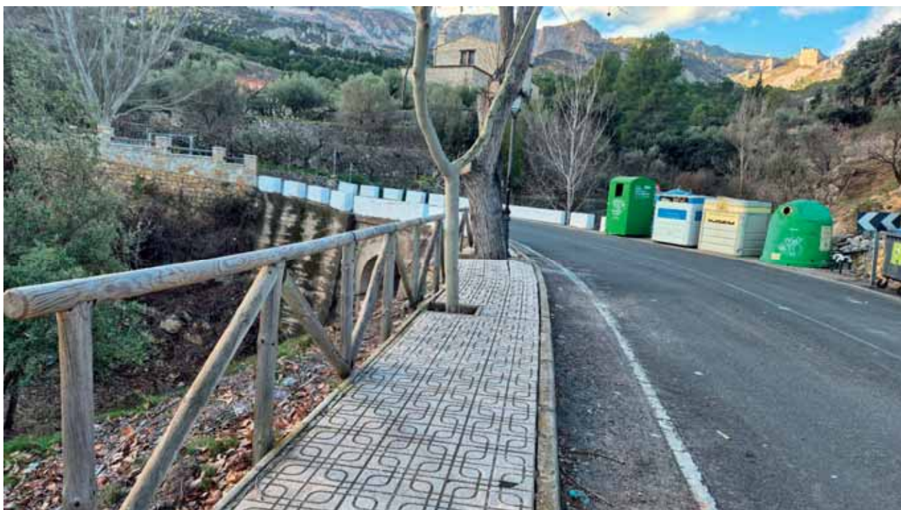
FOTO 2. Vista del paso libre existente en acera con árboles existentes
