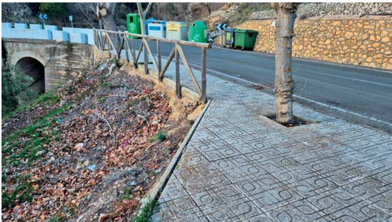
FOTO 1. Vista del inicio de la actuación. Presencia de talanquera de protección
