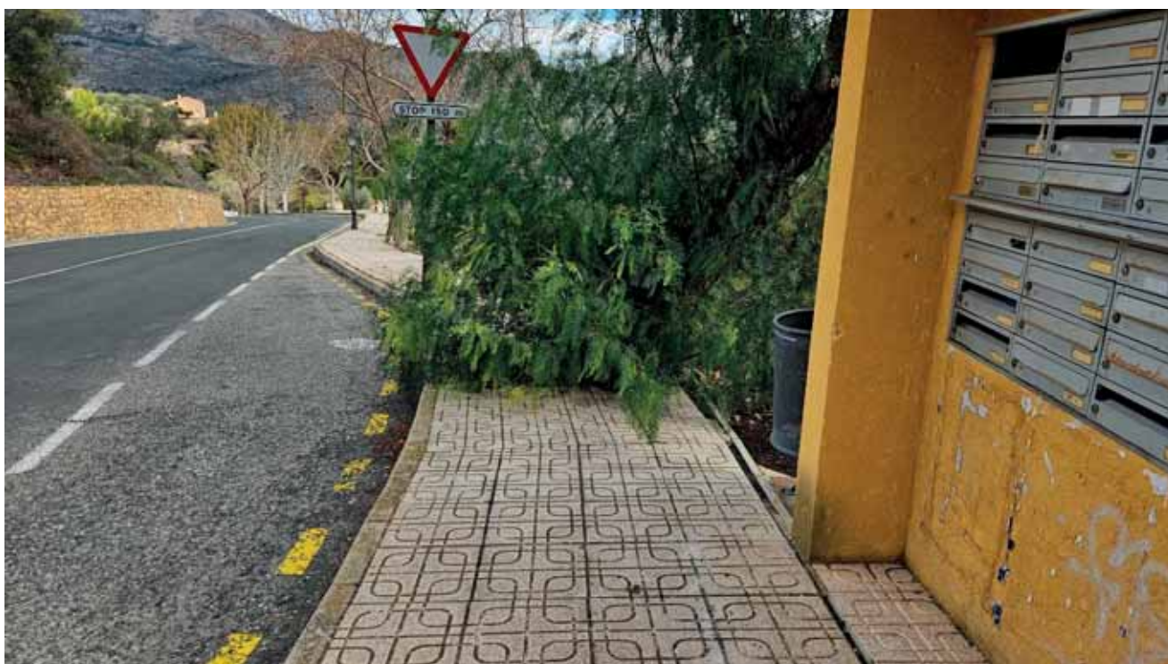
FOTO 6. Presencia de árbol invadiendo el paso en acera.
