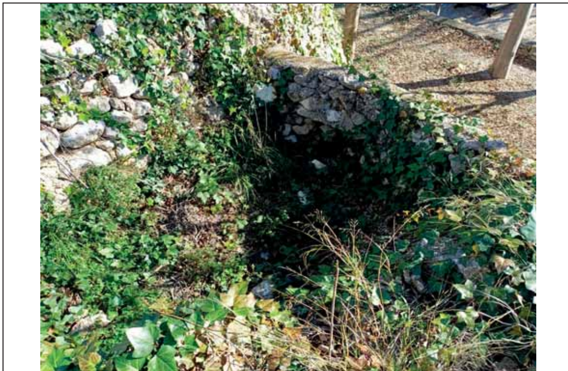
FOTO 09. Zona de balsa. Se proyecta la disposición de una talanquera de protección.
