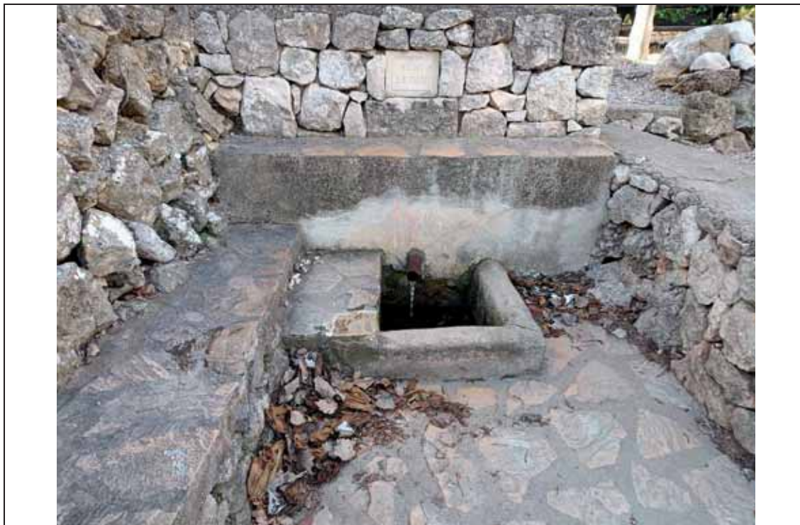
FOTO 11. Frontal y banco de fuente. Se proyecta el chapado del frontal y ampliación de bancada lateral.
