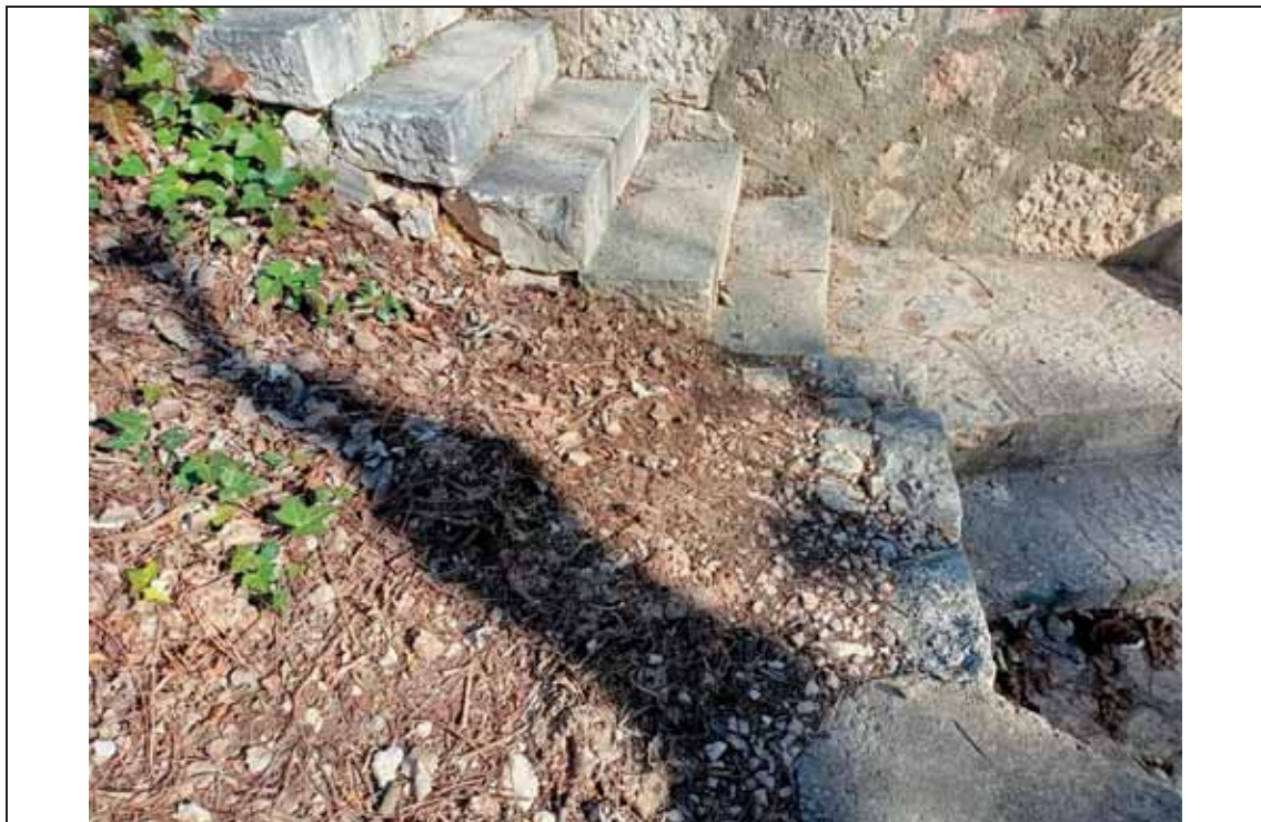
FOTO 08. Zona de ejecución de plataforma de acceso a terraza nº 1.
