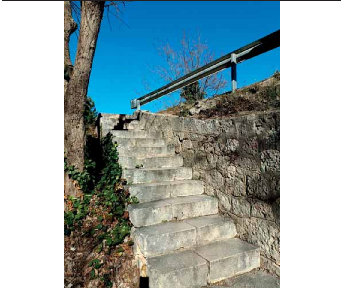
FOTO 03. Acceso a zona verde desde CV-70 por escaleras.
