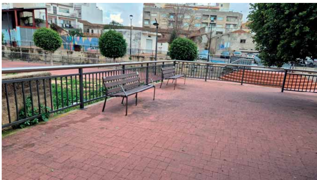
FOTO 8. Vista general del pavimento de adoquín.
