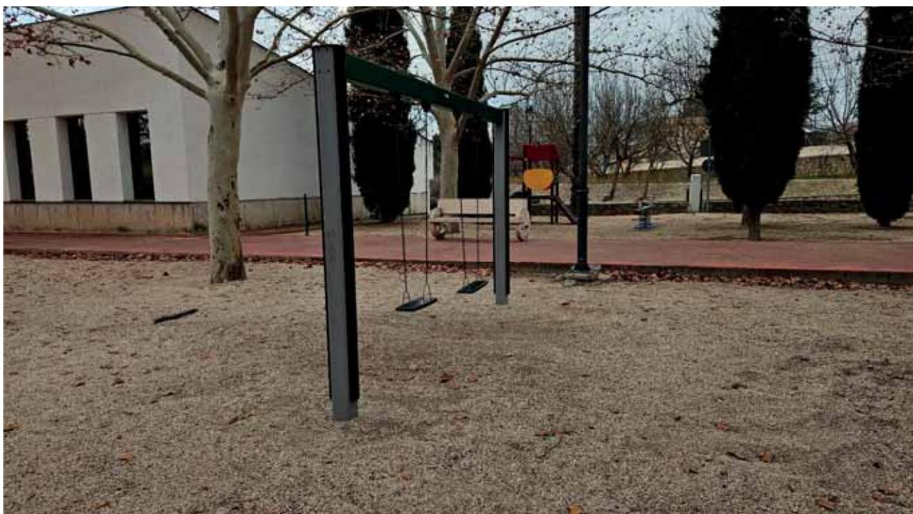
FOTO 4. Columpio existente sobre base de gravilla de canto vivo
