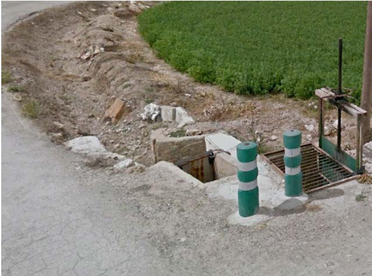
**Fotografía 3.**-Zona del tramo 1 donde se pretende canalizar la acequia, generando un prisma de hormigón con un tubo de PE 315 corrugado que servirá de base para ensanchar la curva del camino que se repondrá totalmente.
