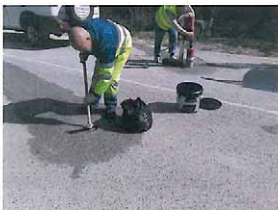
Tapado y extracción de los testigos.
