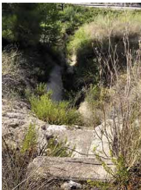
Inicio de canal de drenaje.
