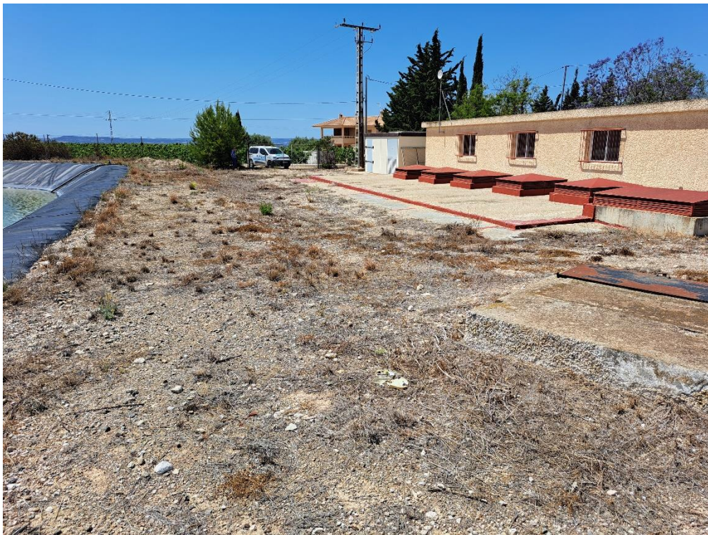
Fotografía 5. Vista de la estación de bombeo y camino sur
