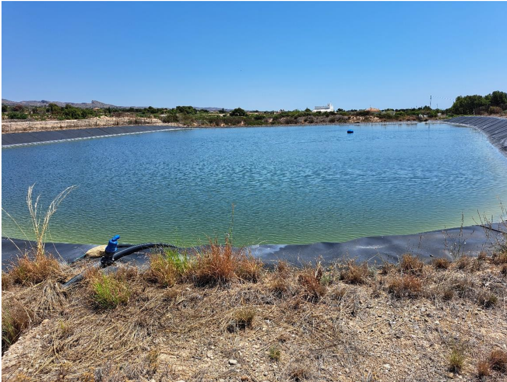
Fotografía 1. Vista general de la balsa
