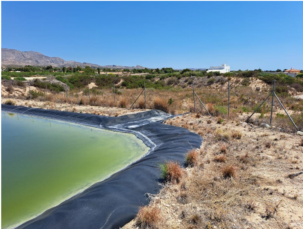
Fotografía 3. Vista del aliviadero de la balsa
