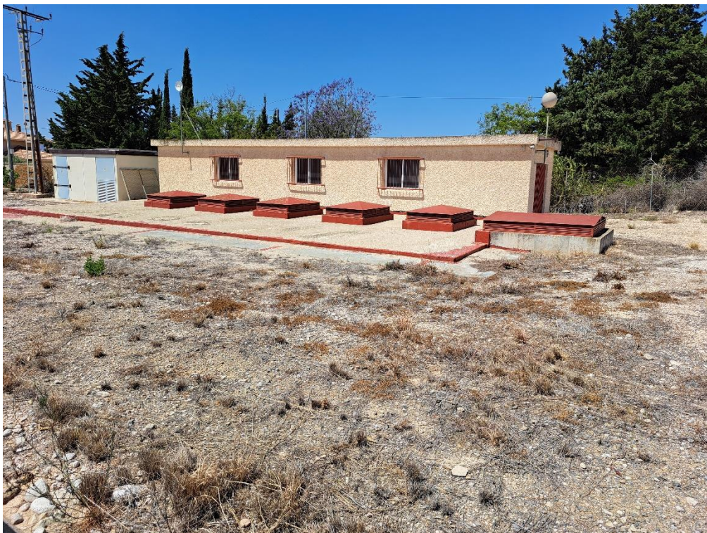
Fotografía 4. Vista de la estación de bombeo
