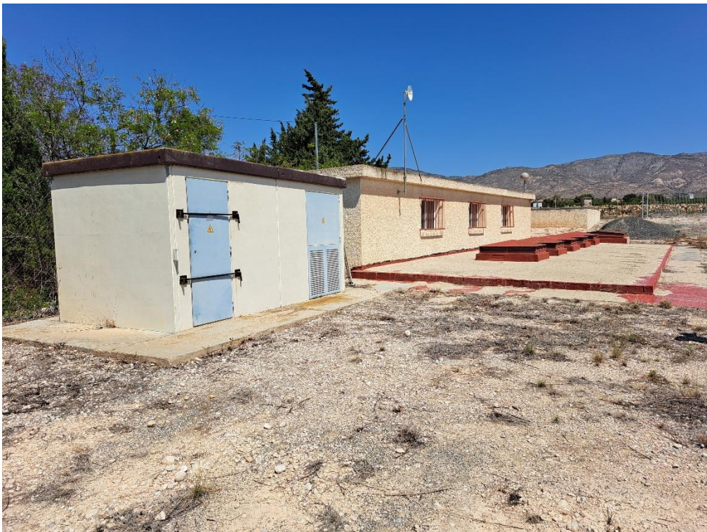
Fotografía 2. Vista de la cubierta de la estación de bombeo y CT existente
